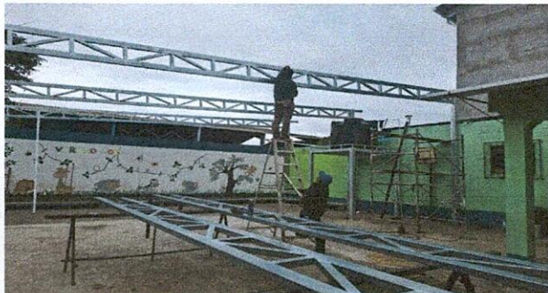
Foto1: mejoramiento de estructura y cubierta de patio
