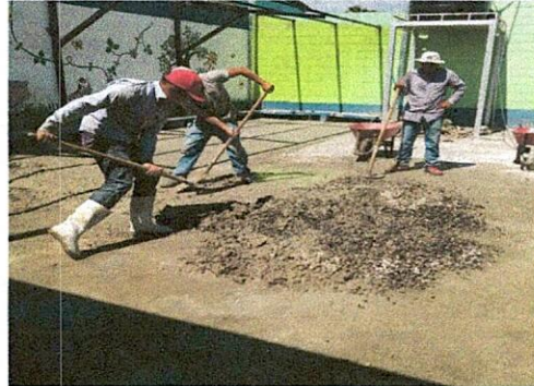
Foto 2: mejoramiento de losa de patio
